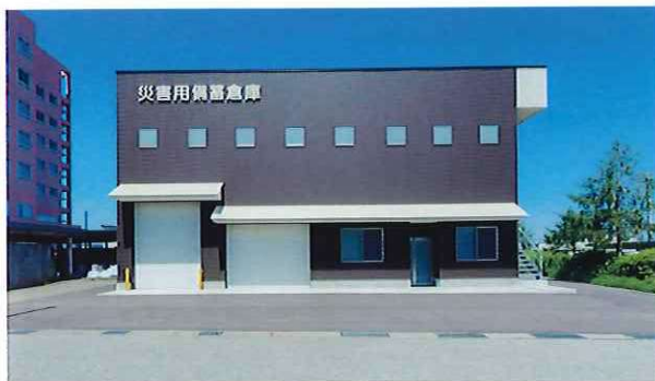
新設された「災害用備蓄倉庫」の外観
